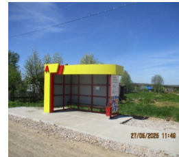
Установка остановочных павильонов
