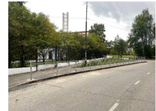
Ремонт тротуара г. Добрянка, ул. Энергетиков
